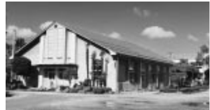
改築される福岡中学校体育館
