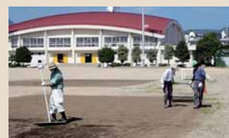
③覆土 汚染されていない土を敷きならし、踏み固めます
