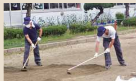
②土の削り取り 特定したエリアの土を2cm程度削り取ります
