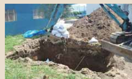
④施設内に埋める 削り取った土壌は施設内に適切に埋めます
