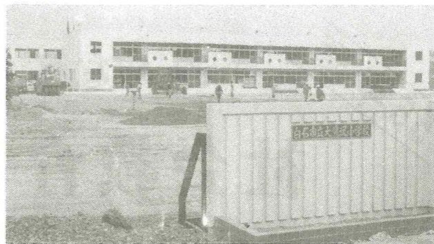
▲完成した新校舎
