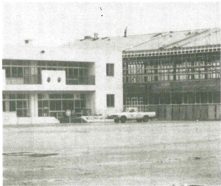
新校舎と工事中の体育館
