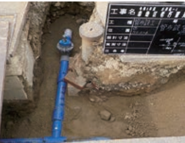
▲幸地区の更新した配水管（耐震管）
