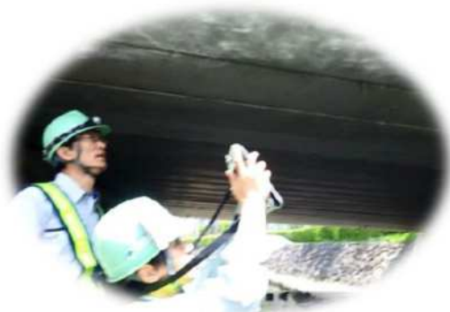
【タブレットによる点検】
