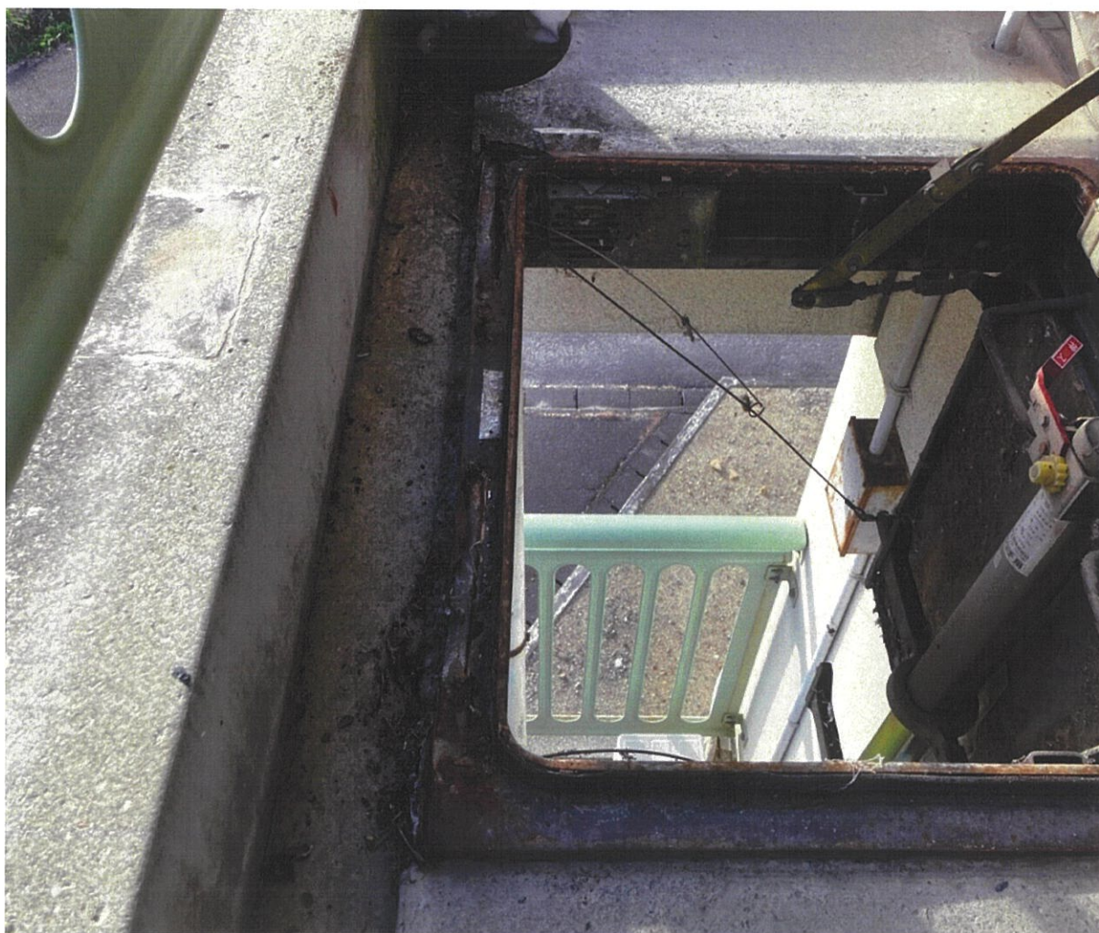
避難ハッチ老朽化につき交換
