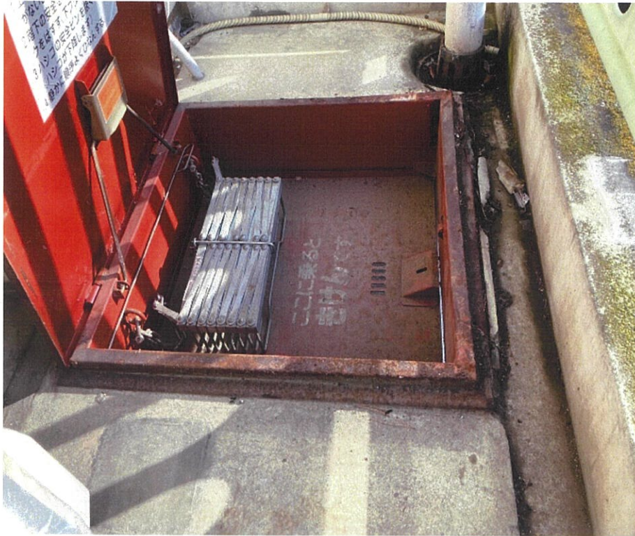
避難ハッチ老朽化につき交換
