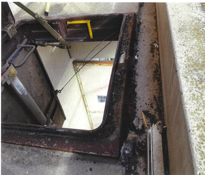
避難ハッチ老朽化につき交換
