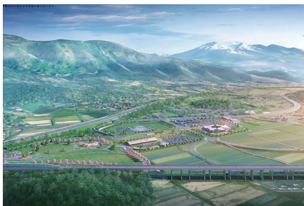
▲(仮称)白石中央スマートインターチェンジ周辺整備の工事が本格化【土木費】
