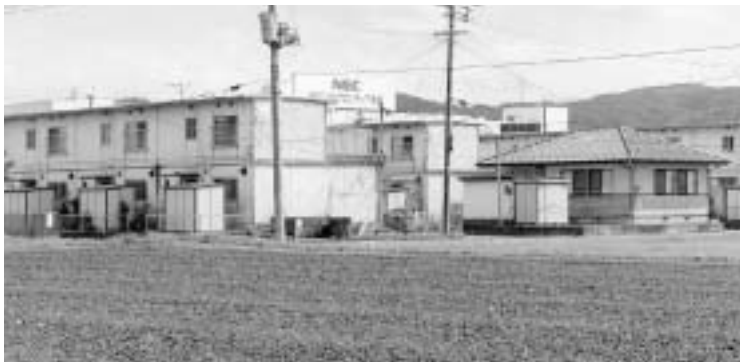
火災報知器が設置される桜田住宅
