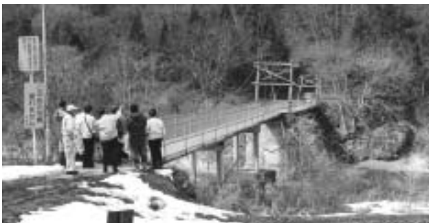
吊橋撤去工事の現地調査
