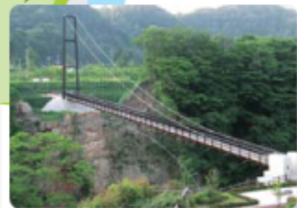
スパッシュランド大吊橋 スパッシュランドとスパッシュランドパークを 結ぶ夢の架け橋「スパッシュランド大吊橋」が 開通しました。(全長73m、幅1.6m)
