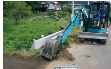
▲市道原線の除染作業を行いました
