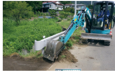
▲市道原線の除染作業を行いました
